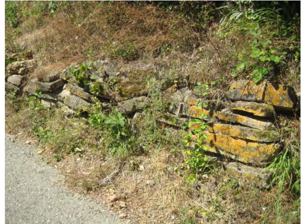
Abb. 16: Trockenmauer am Talberghang Söllingen
